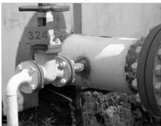
Рис 2. Примеры дефектов трубопроводов, обнаруживаемых при визуальном осмотре: а – сварные секционные отводы, б – сварные переходники, в – приварка патрубков без усиливающего воротника, г - заплата
