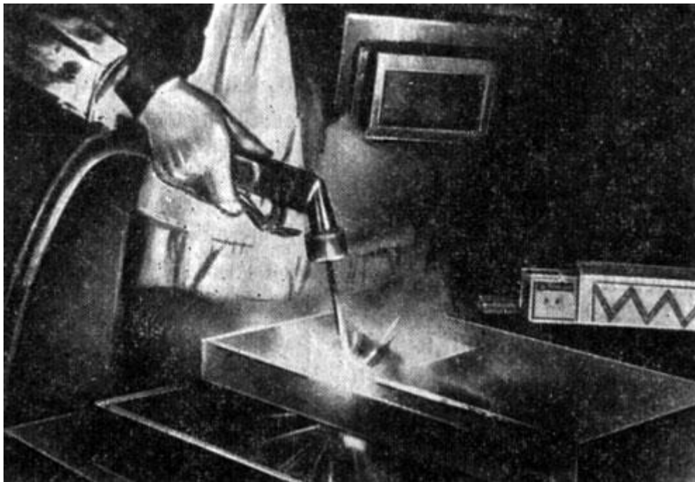
Фиг. 65. Кислородно-дуговая резка трубчатым электродом
